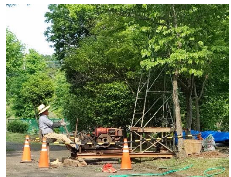
災害用井戸掘削工事の様子 (中央公園南側)
