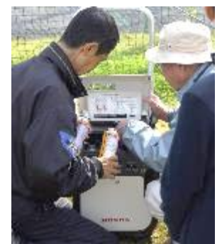
ガスボンベ式発電機
